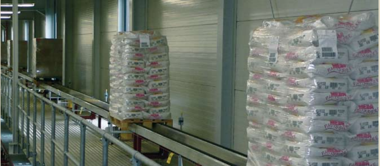
50 m lange Förderbrücke über öffentliche Gleisanlagen
