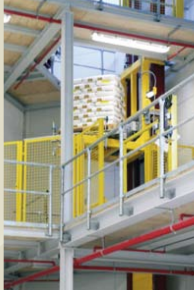
Aufzug zur Förderbrücke
